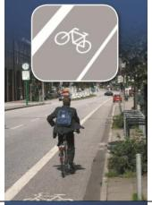
Der Radfahrstreifen ist mit Zeichen 237 StVO gekennzeichnet und benutzungspflichtig. Zum Kfz-Verkehr wird der Radfahrstreifen durch den Breitstrich (Zeichen 295 abgegrenzt)
